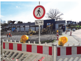
Foto © Stadt Essen, Amt für Straßen und Verkehr Baubeginn
