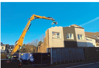
Foto © Stadt Essen, Amt für Straßen und Verkehr Abriß der städtischen Immobilie Alte Hauptstraße 110
