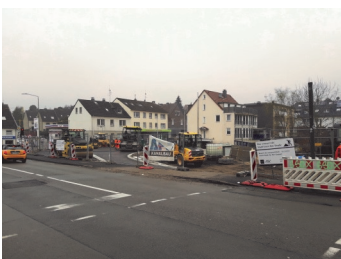
Foto © Stadt Essen, Amt für Straßen und Verkehr Stand der Bauarbeiten im April 2021
