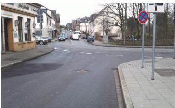
Foto © Stadt Essen, Amt für Straßen und Verkehr Blick auf den Knotenpunkt aus der Laurastraße vor Baubeginn
